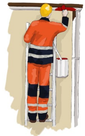
Rys. 1. Malowanie z drabiny przy utrzymaniu trzech punktów kontaktu z drabiną
