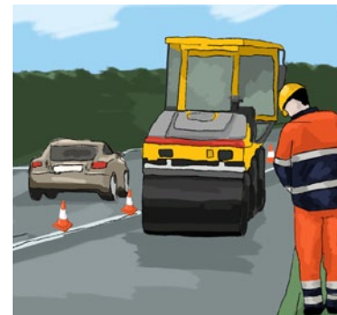
Rys. 1. Wygradzanie robót pod ruchem za pomocą pachołków
