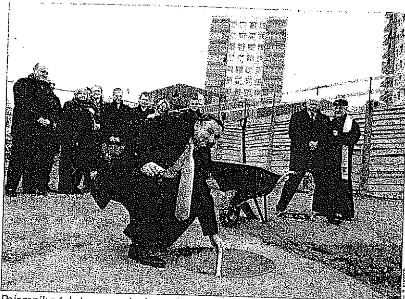
Pojemnik z tekstem przesłania, czyli kamień węgielny wmurowany został w ławę fundamentową przyszłego 18-kondygnacyjnego budynku. Tekst przesłania umieszczył w fundamencie Jacek Więcek, wiceprezes Zarządu Towarzystwa Funduszy Inwestycyjnych Skarbiec.
